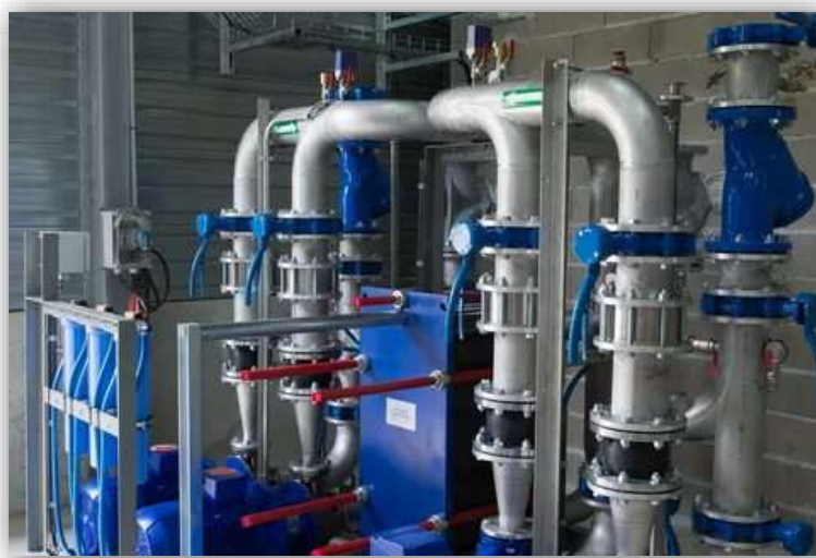
Рис. 4. Электропривод насосных установок
