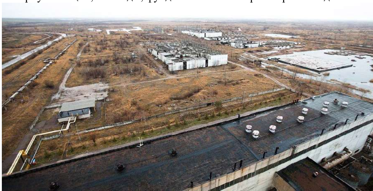
Рис. 3. Недостроенная АЭС. Справа расположены фундаменты для реакторов
