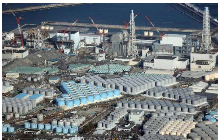
Рисунок 1. Резервуары для хранения радиоактивной воды на территории АЭС «Фукусима»
