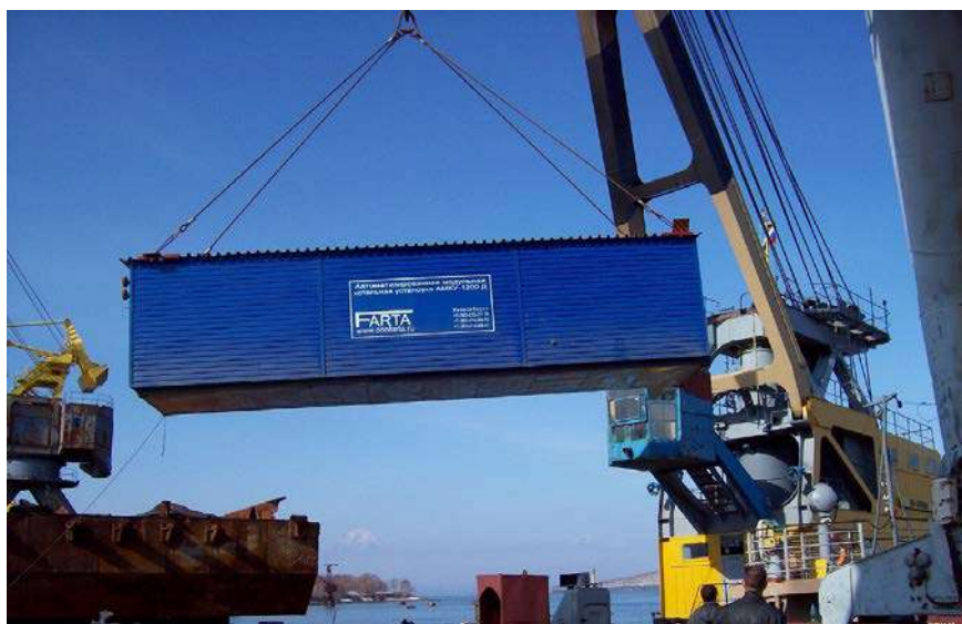
Рисунок 1. Транспортировка блочно-модульной котельной
